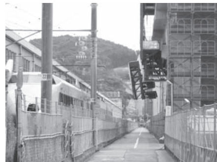
写真-2 博多総合車両所側
