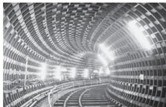
写真一 鋼製セグメント区間状況
