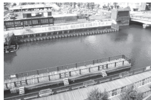
写真-2 護岸矢板打設後の状況
