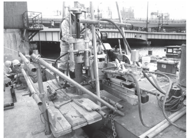
写真一四 ボーリングマシンによる試料の採取状況 写真左側が旧護岸，ボーリングマシンは作業台船に乗せている。
