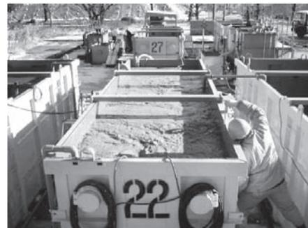
写真一 粘性土の洗浄無害化処理実施状況
