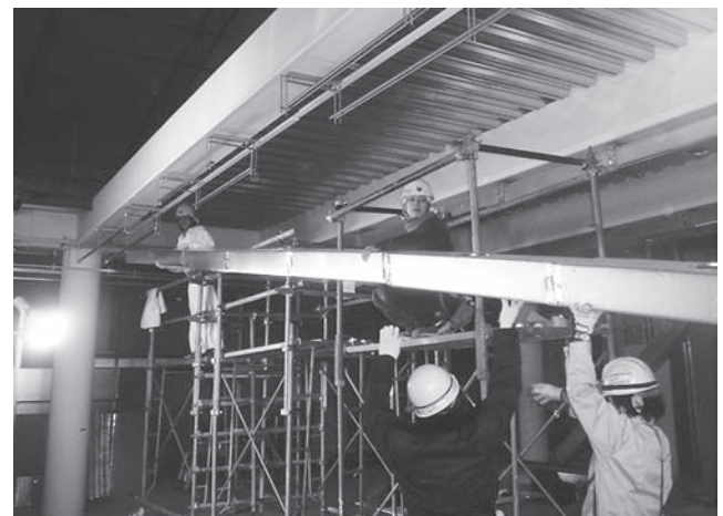
写真—3 9.6mのダンボールダクト吊り込み施工例
