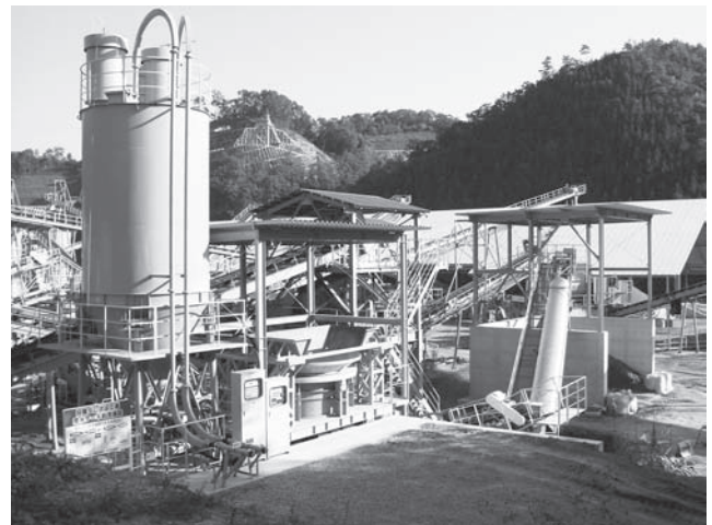
写真-1 ケークルⅡ 50型の全景 (国土交通省 灰塚ダム工事現場)
