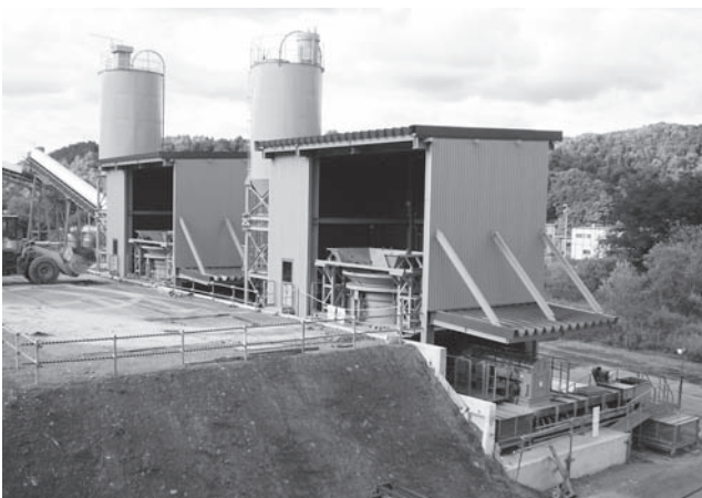
写真一4 稼働状況 (北海道開発局 夕張シュエバダム工事現場)
