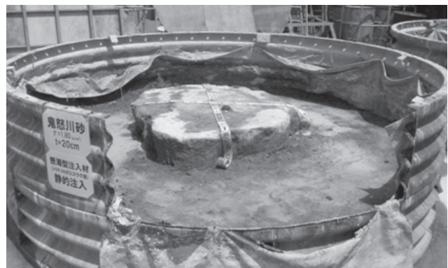
写真—3 静的注入による試験結果（改良径：1 m）
