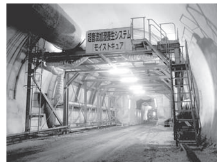
写真一 「モイストキュア」施工状況
