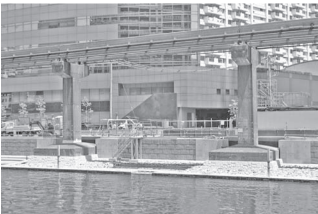
写真—3 カニ護岸設置箇所
