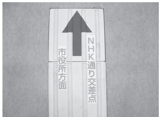
写真一 路面標示の例
