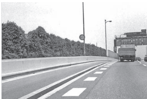
写真二 1号羽田線高架部の緑化
