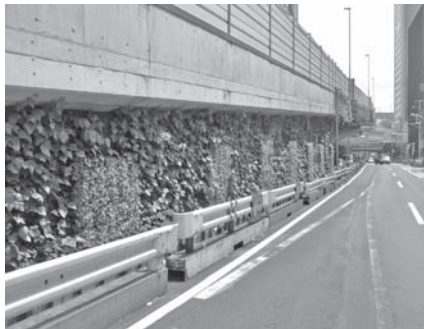
写真-4 西新宿ジャンクションの緑化（擁壁区間）
