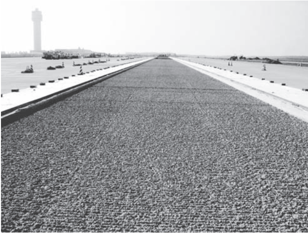
写真一 2 表面処理が完了し、コンクリート打設前の状況
