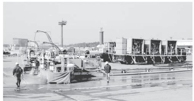
写真一3 表面処理機(左)と超高圧ポンプ(右;3台)
