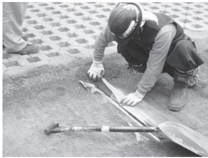
写真-3 給水パイプ敷設
