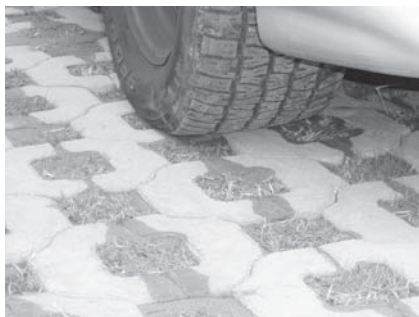
写真-5 シバ張りと客土
