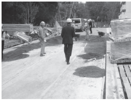
写真-2 導水シート敷設
