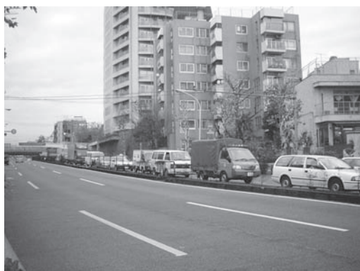
写真—5 施工後の状況 (都内)
