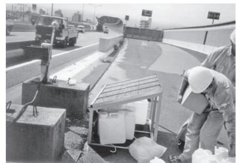
写真一 高速道における NOx 処理量測定状況
