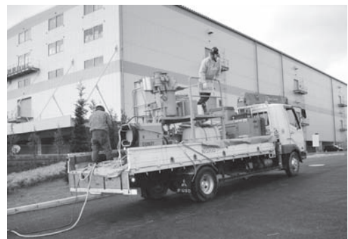
写真二 フォトリード工法施工プラント (トラック搭載部分)
