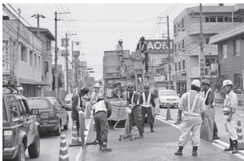
写真一 フォトリード工法施工状況
