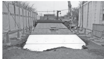
写真—5 地中貫入状況
