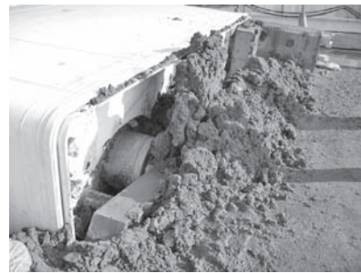
写真—4 アプローチ区間掘進状況
