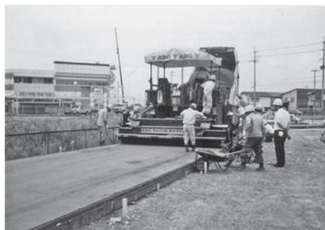
写真2-14 ABG(独) TITAN411 RCCP施工
