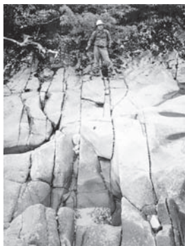
写真一七 万才谷河床岩盤（安山岩溶岩）の割れ目の状況
