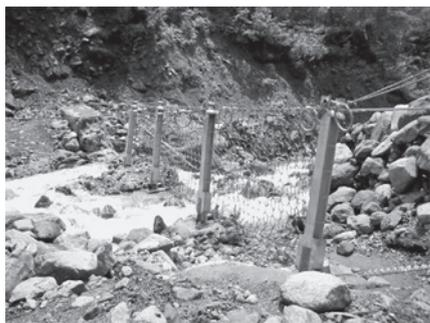
写真一 11 TAMPO バリア設置事例② (富山県)
