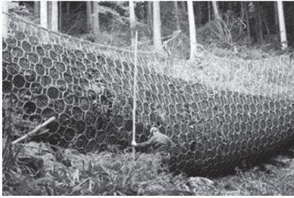
写真一六 リングネット落石防護柵による土砂捕捉事例 (奈良県)
