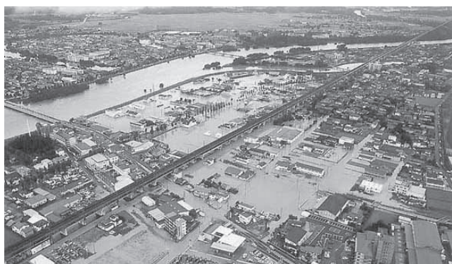
写真—1 冠水した住宅地
