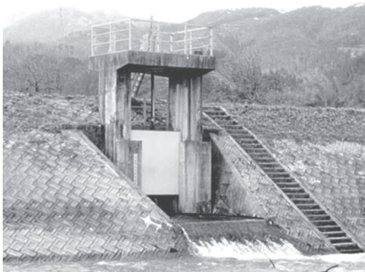
写真—2 改修前（従来型のゲート）
