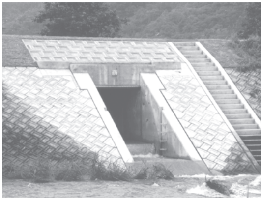
写真—3 改修後（KaNaF ゲート）
