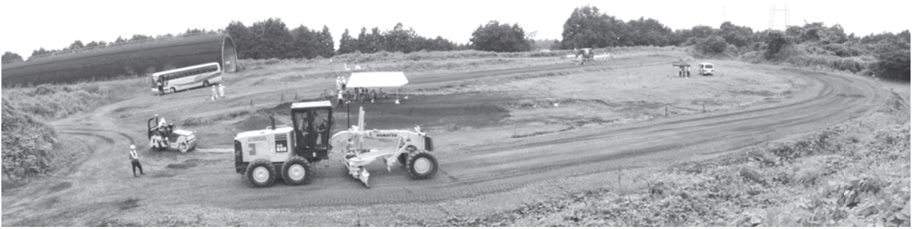
写真-2 屋外実習ヤード状況
