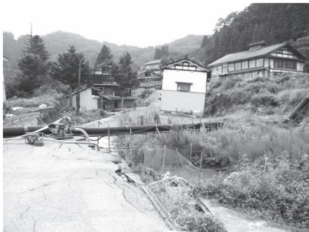
写真一 家屋の陥没・最大3m程度
