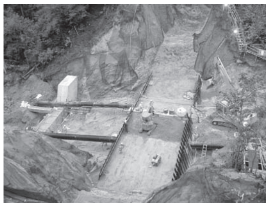
写真-7 施工状況
