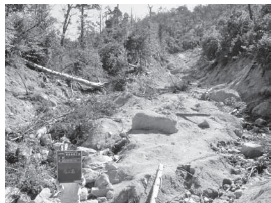
写真2 本堤施工箇所
