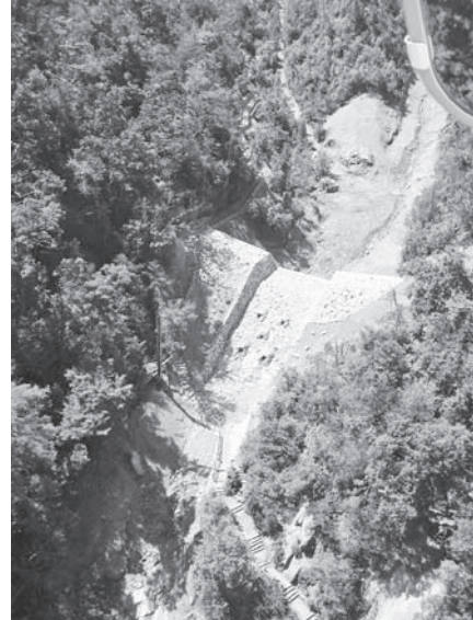
写真—10 完成写真
