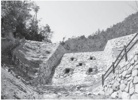
写真—8 堰堤完了全景
