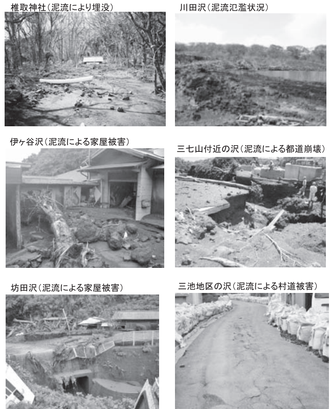
図-2 泥流による被害状況
