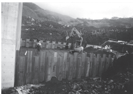
図一8 ダブルウォール構造堰堤の施工状況
