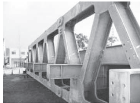
写真一2 既往の応急橋の一例
