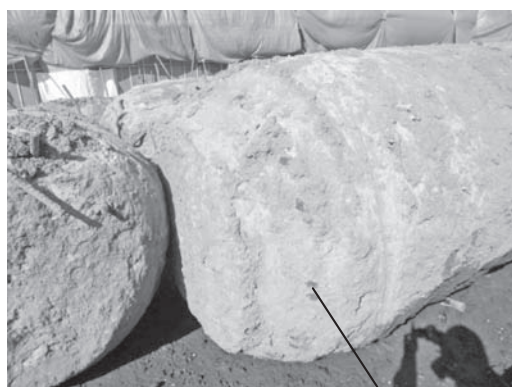
写真-3 切断した杭の除去
