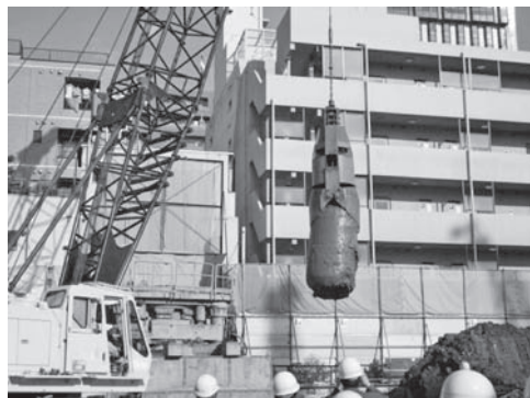
写真-3 切断した杭の除去
