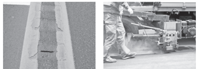
写真—5 溝が埋まった事例（左）とスプレー式の施工状況（右）
