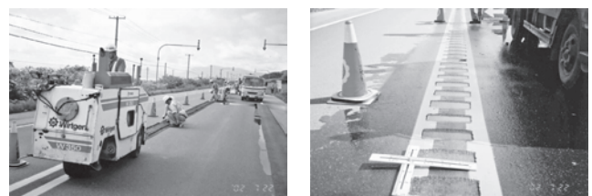
写真一6 一般国道5号八雲町におけるランブルストリップスの施工状況
