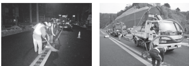
写真—3 汚泥吸排車（左）と専用廃材吸引車（右）による清掃状況
