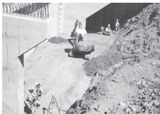
写真—1 構造物裏込め部の状況
