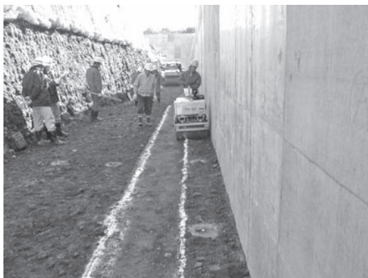
写真一 2 小型施工機械による構造物裏込め
