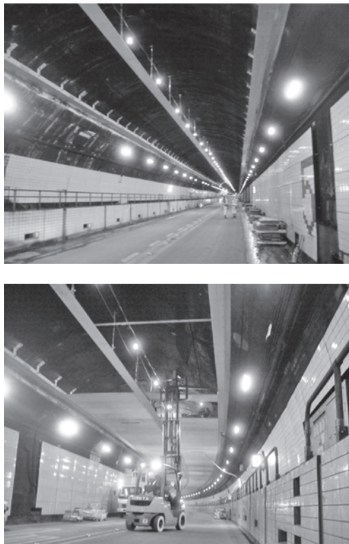
図一八 新設吊金具・天井板設置状況
