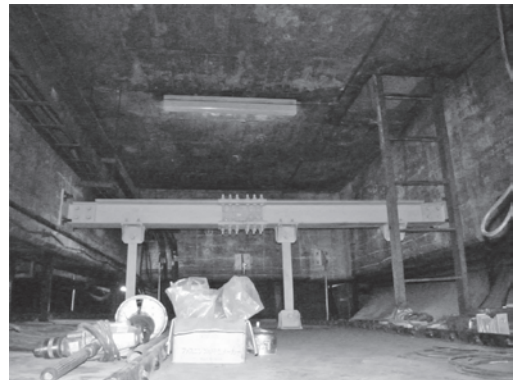
図一九 合金溶射吊部材設置状況
