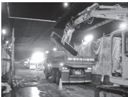
図一6 撤去状況
