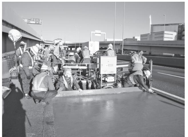
写真一5 SFRC 打設 (機械施工②)
