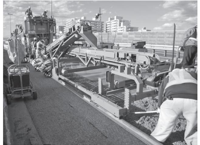
写真一4 SFRC 打設 (機械施工①)
