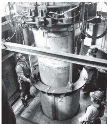
写真-2 補強鋼板圧入
