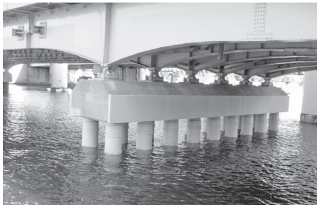
写真一七 完成状況（多柱式基礎）
