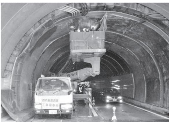
写真—3 TDR ショット工法吹付け状況
