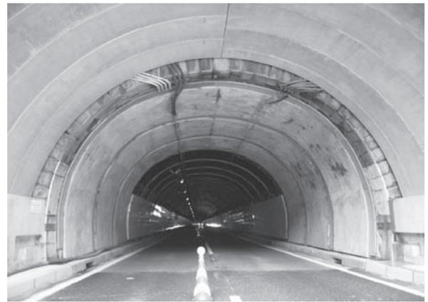
写真—4 覆工補強完成
