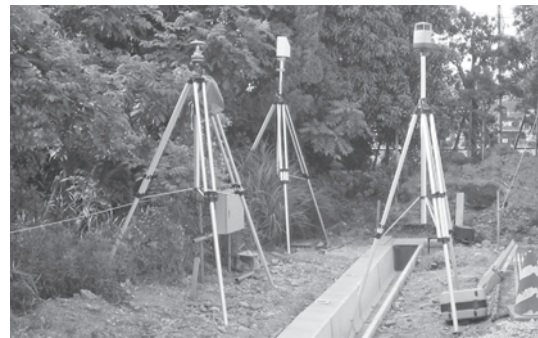
写真-1 GNSS式基地局設置状況
