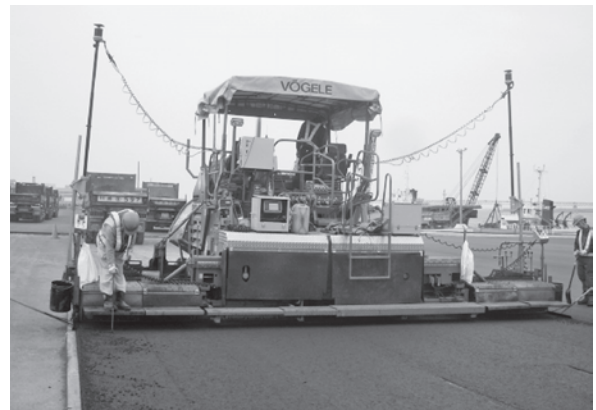
写真-5 GNSS式基層施工状況
