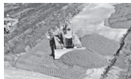
RCC 敷均し状況
