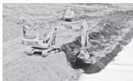
土砂型枠整形状況
