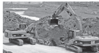
フォーミング・ブレードによる土砂型枠施工状況
