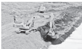
土砂型枠整形状況
