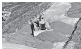
RCC 敷均し状況
