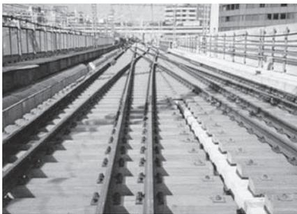
図—12 合成まくらぎ直結分岐器
