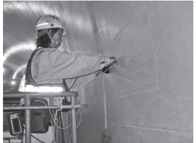
写真-2 調査状況
