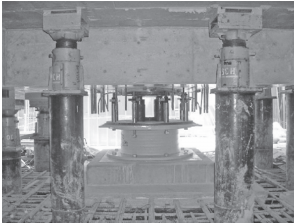
免震装置へ荷重の移し替え
