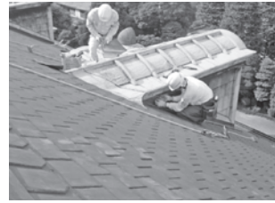
ドーマー銅板屋根
