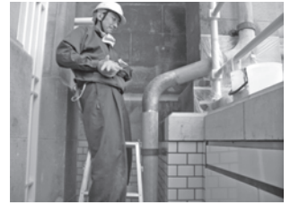
竖樋曲がり部交換
