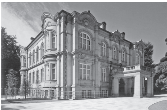
東・北面車寄せ外観
