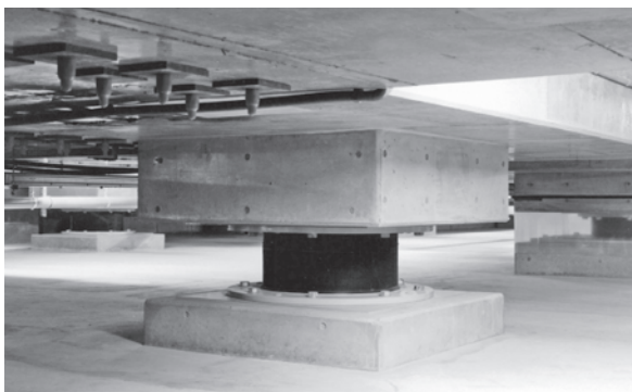
免震装置設置完了
