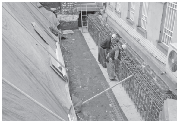
既存基礎両脇補強梁配筋
