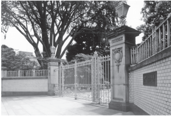
改修前門扉・塀
