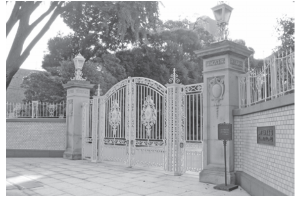
門扉・塀鉄柵復元完了（門柱は移設）
