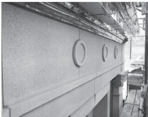
図一7 現地での擬石の施工
