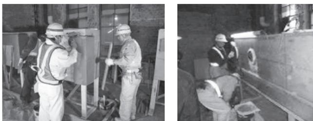
図一6 擬石の試験施工
