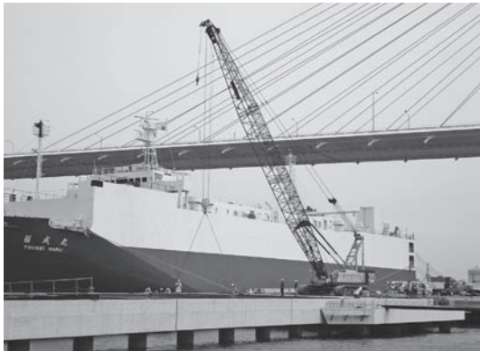
写真一五 PC桁架設状況(1)
