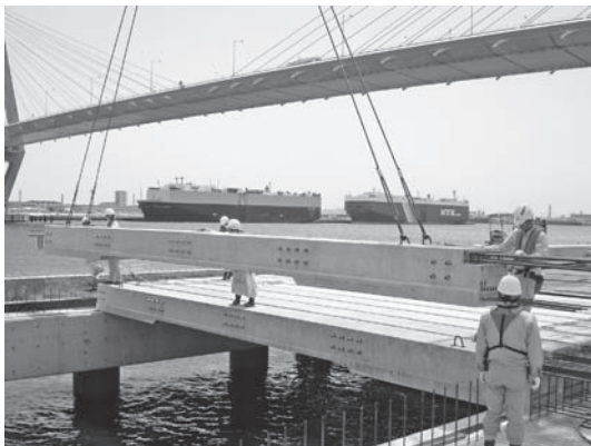
写真一六 PC桁架設状況(2)
