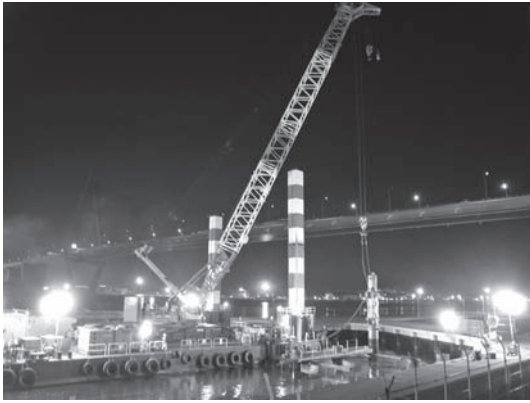
写真一 鋼管杭打設状況
