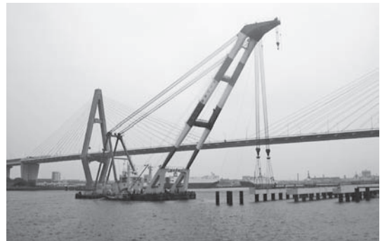
写真一3 プレキャスト受梁架設状況 (1)
