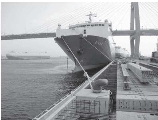
写真一2 工事期間中の係留状況
