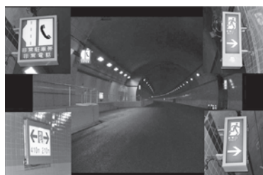
トンネル内誘導表示板
