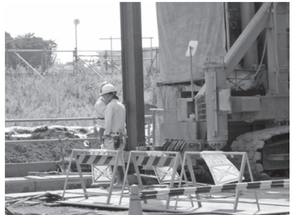
写真-5 芯材投入状況（後日撮影）
