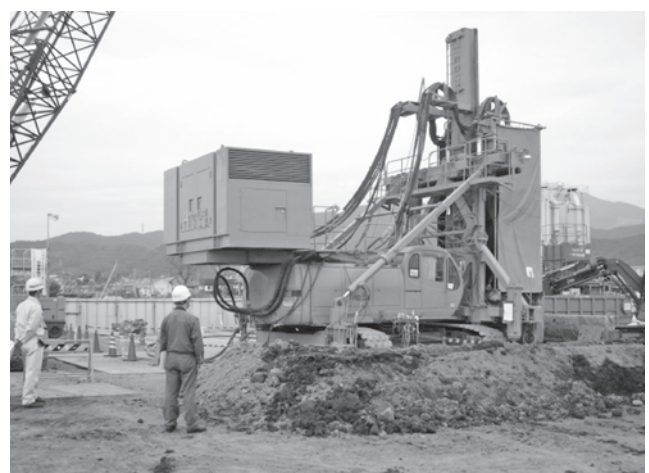
写真二 施工状況
