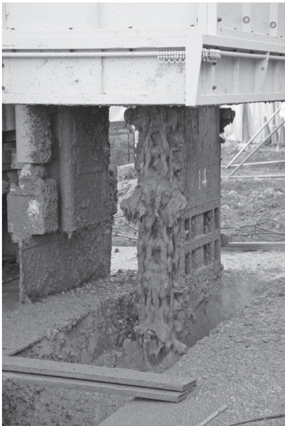
写真-3 掘削中のカッターポスト
