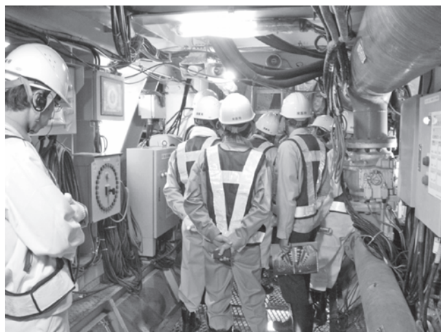
写真一 三 シールドマシン機内
