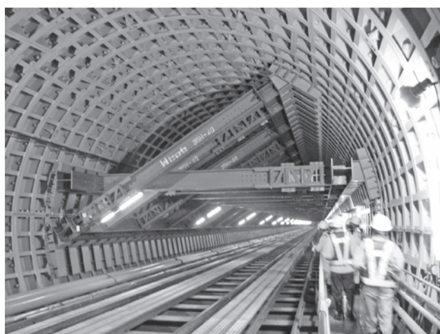
写真一 五 シールド内補強工
