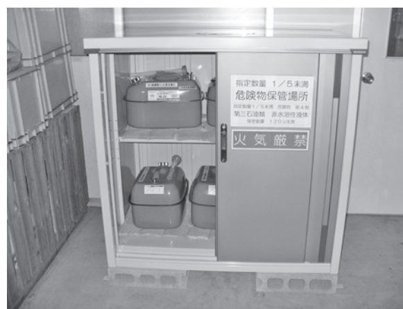
写真一 4 BDF 専用保管庫
