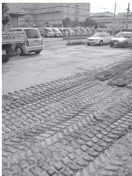
写真-3 ゴムクローラの転用事例
