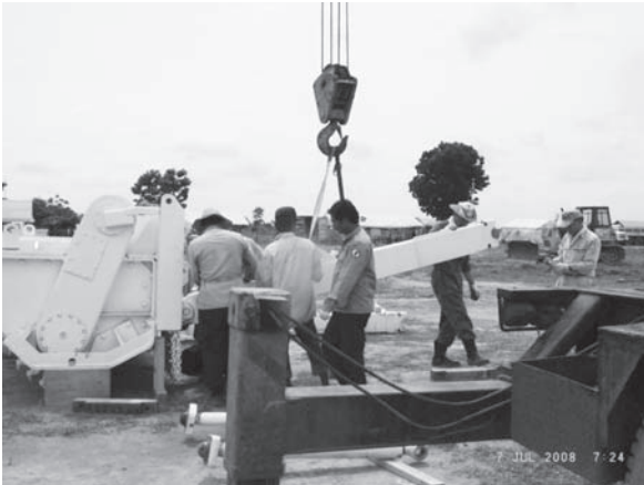
写真—4 組立作業訓練
