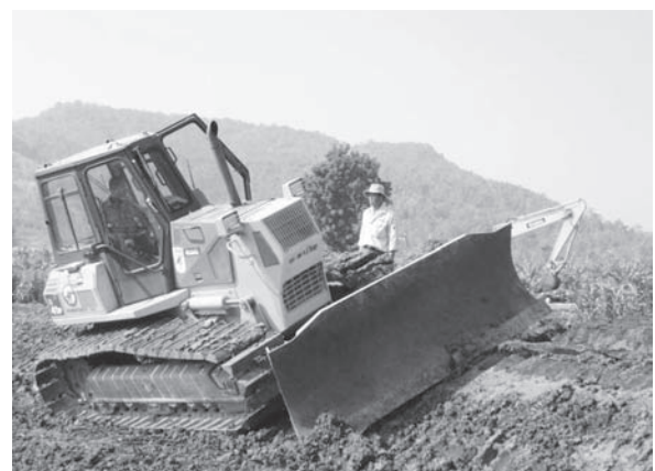
写真-3 側壁成型施工方法の実施訓練
