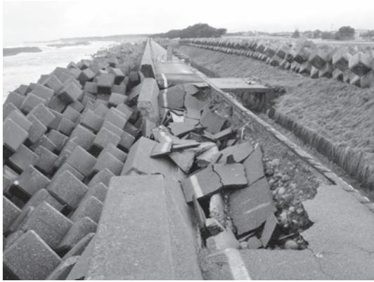
図-2 海岸堤の倒壊
