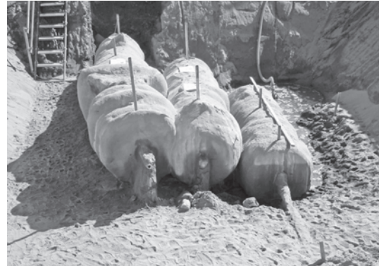
図一八 水平施工の改良体（左は R=38m の曲線施工）
