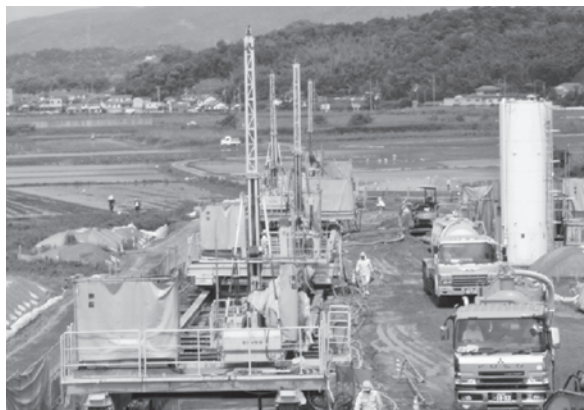
写真-4 北部水路(その4)工事NJP施工状況
