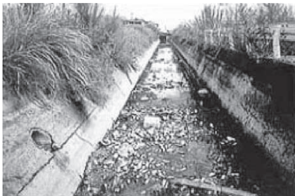
写真一1 用排水兼用開水路の現況
