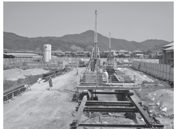
写真-3 開削部のNJP施工状況
