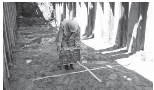
写真-5 水路部開削によるNJP改良確認状況
