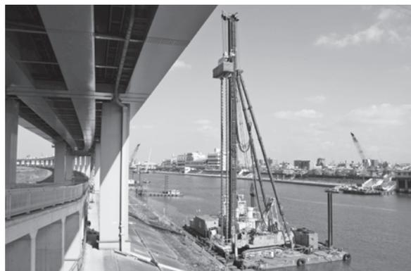
写真-2 WHJ 工法と護岸施工状況
