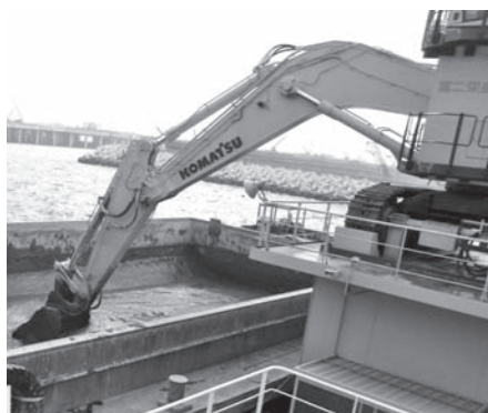
写真一 1 解泥・揚土
