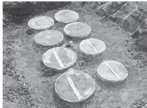
写真-1 杭頭確認状況 (φ 1,300 mm)
